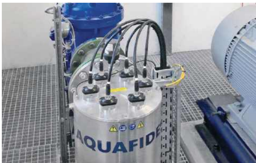
Katadyn France distribue les réacteurs compacts de la gamme Aquafides UV. Basés sur la désinfection UV basse pression, ils inhibent la duplication des micro-organismes afin de rendre l'eau potable du point de vue microbiologique.
