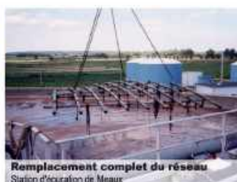
Changement des diffuseurs stations d'épuration de St Omer
