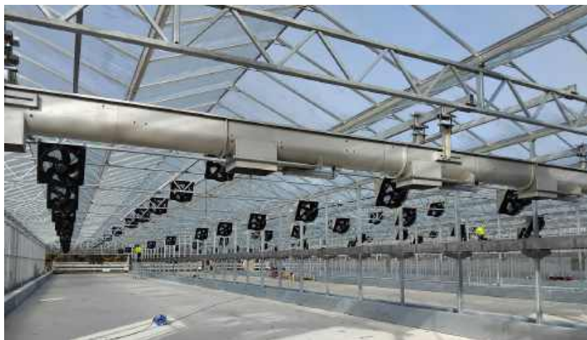
Un séchage solaire sur une STEU de 86 000 équivalents-habitants est en cours d'installation à Valff, où interviennent notamment les sociétés Huber Technology, Sodimate et Sources.
