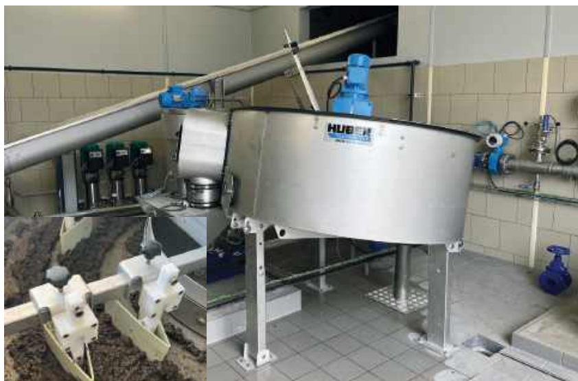
Huber Technology introduit actuellement en France une technologie exclusive développée il y a une vingtaine d'années: les épaisseurs à disque S-Disc. Il s'agit de plateaux circulaires inclinés, sur lesquels sont injectés la boue et le polymère.
