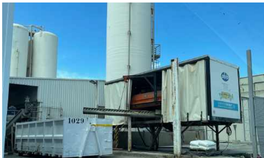
Pour Centriboet, louer une unité mobile pour la déshydratation des boues par centrifugation est une bonne option dans le cas de besoin de maintenance, de dépannage ou de changement des équipes en service.
