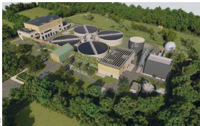
La nouvelle station d'épuration Sélène de La-Roche-sur-Yon sera équipée de tambours d'égouttage avant méthanisation et d'un pré-sécheur avant incinération.
