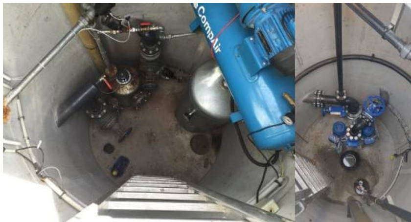
Side Industrie remplace beaucoup d'aéroéjecteurs par des pompes en ligne DIP Système. Cela permet notamment de s'affranchir des compresseurs, des réservoirs d'air comprimé, des sécheurs d'air, de l'automatisme du système de compression, etc.
