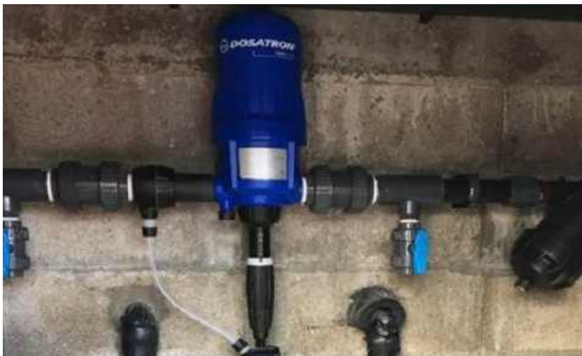
Le type de pompes doseuses de Dosatron (ici, le modèle D9WL) est déjà utilisé dans certains projets de réutilisation des eaux usées traitées (REUT).
