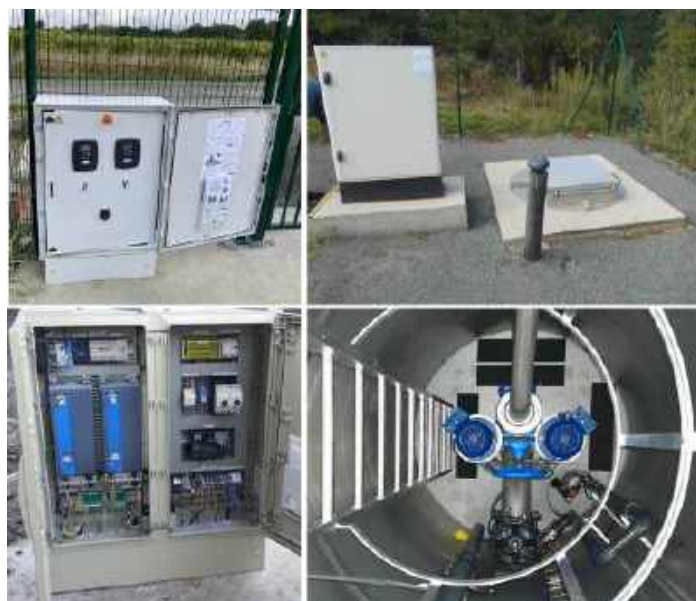
Side Industrie propose, ici, un poste de relevage DIP (pompage en ligne directe) complet avec son armoire et ses variateurs de vitesse.
