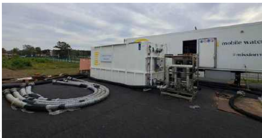
Dans le cas d'un projet de réutilisation de 70 % des effluents de la STEP sur une laiterie, Nijhuis Saur Industrie utilise des technologies membranaires. Les effluents traités sont réutilisés pour le nettoyage en place, à l'exception du dernier rinçage.
