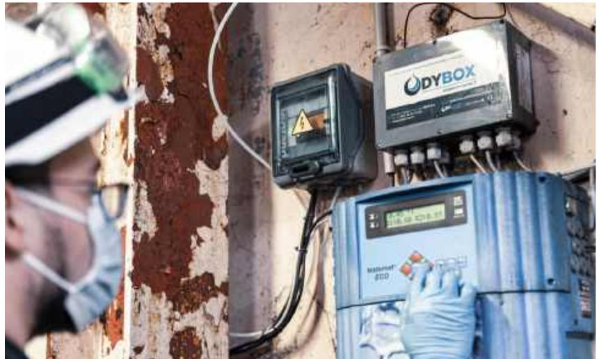
Les boîtiers Odybox peuvent équiper des TAR, des chaudières, des circuits d'eau et remonter les données (volume, pH, températures, consommation de réactifs...) en Modbus.
