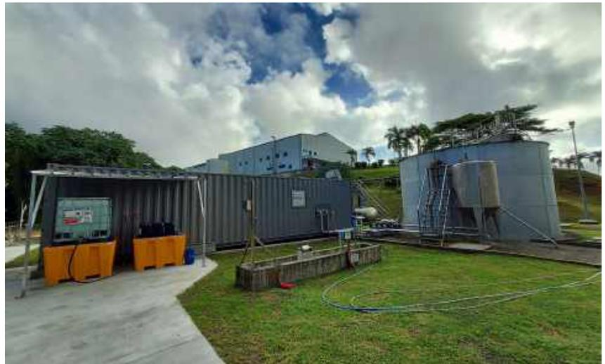
Exemple d'un reuse sortie de step, 6m<sup>3</sup>/h, dans une usine de yaourt, une installation faite par Atlantique Industrie (qui a intégré le groupe Aquasphère en 2024).
