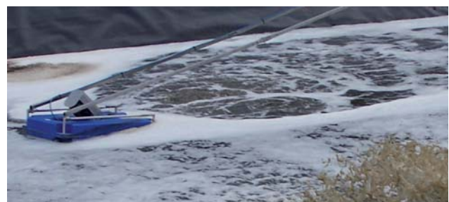
Hydropulse en lagunage de lixiviat, ici en fonctionnement avec Flopulse
