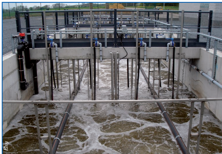
Pour les collectivités de plus de 150 EH, Eloy a mis au point l'Airoxy®. Cette station d'épuration biologique utilisant le procédé de la boue activée de type SBR a été conçue pour neutraliser, grâce à son volume tampon intégré, les effets néfastes des incessantes variations de charges qui caractérisent les effluents de ces populations.
