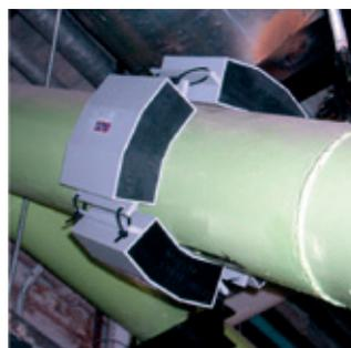
élevés. Ils empêchent et suppriment la corrosion dans les circuits de chauffage.
