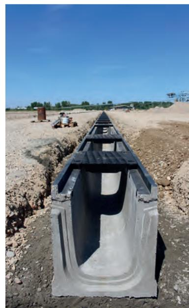
**Bircomax-i ne nécessite pas d'enrobage complet béton.**
