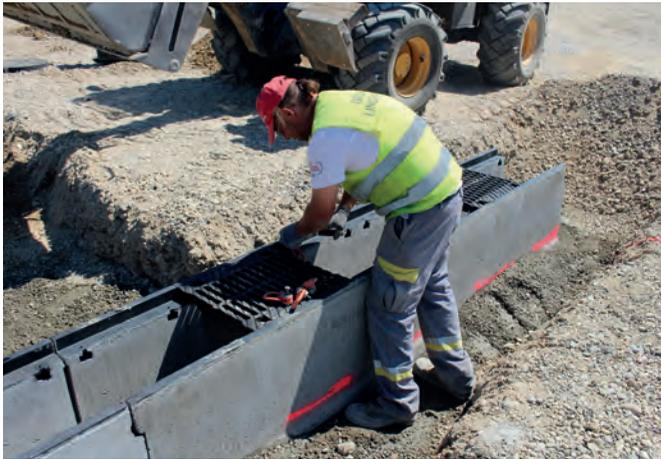
**Tous les modèles se posent aisément à la verticale, grâce à un système ne nécessitant que 4 crochets de levage, permettant de glisser le caniveau dans des tranchées, mêmes étroites.**
