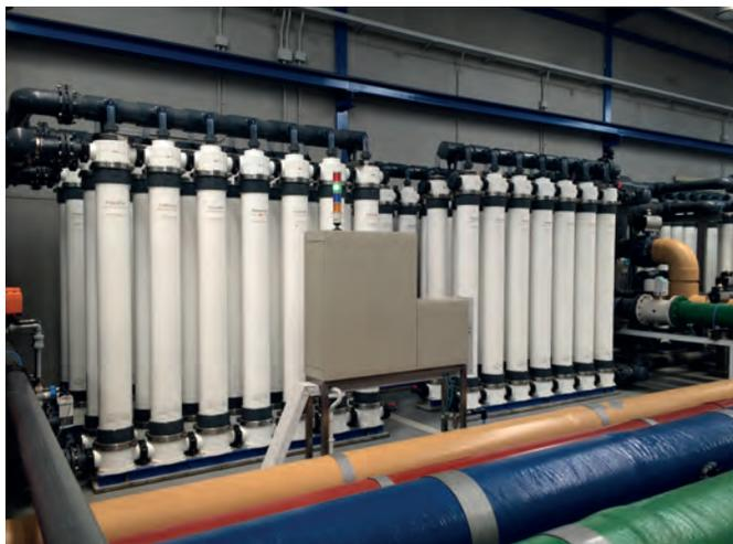
**L'ultrafiltration a permis à l'usine de Maspalomas de fournir de l'eau de qualité à la région et en quantités plus importantes. La compacité des châssis Dow IntegraPac a également contribué à réduire l'emprise du process sur le site de 40 % par rapport aux filtres à sable.**
