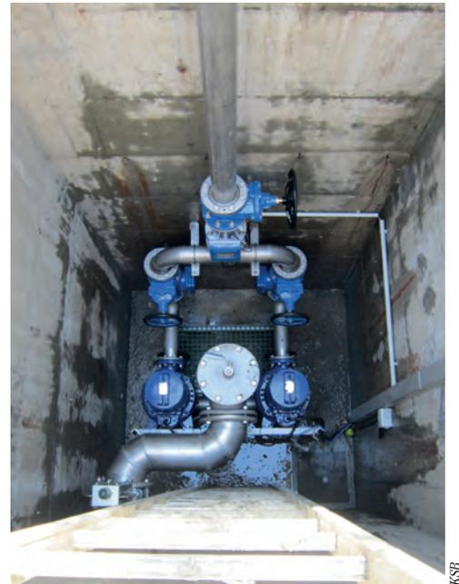
La SRL, station de relevage en ligne, supprime le stockage des eaux polluées, le dégrillage et le curage. Elle est équipée, en fosse sèche, de 2 pompes pompes monobloc verticales à volute, fonctionnant en variation de fréquence, optimisées pour les eaux usées. La section de passage intégral ainsi que les roues profilées évitent le bouchage.
