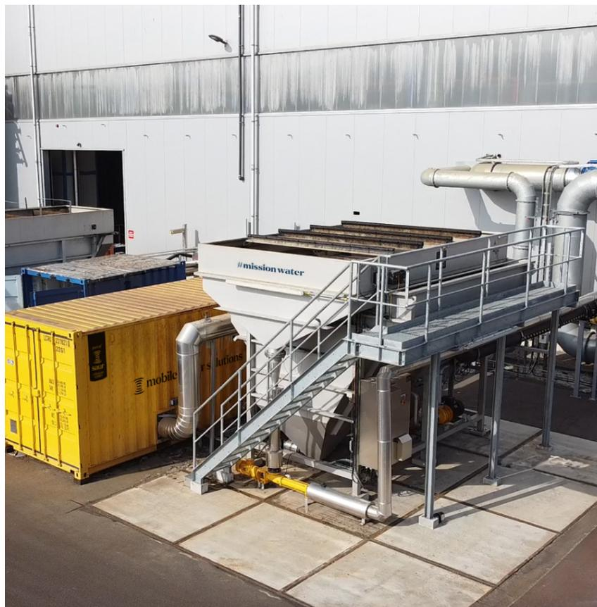
développée pour éliminer efficacement les solides en suspension, les huiles et graisses, ainsi que les particules coagulées et floculées. Elle répond ainsi aux besoins de traitement variés des eaux usées. Le système est particulièrement adapté pour gérer les débits et charges élevés d'eaux usées et pour faire face aux fluctuations fréquentes
