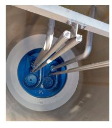
Le fond de cuve PreroClean de Hidrostal est une version simplifiée et standardisée du système Prerostal. Grace à la mise en rotation du liquide avant le pompage, l'ensemble des matières en suspension et des particules est pompé. Ce nettoyage a lieu une fois par cycle de pompage. Ainsi, le puisard reste propre et aucune accumulation de solide n'y est possible.
