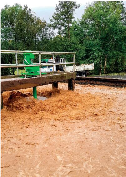
Une gamme de turbines d'aération conçues pour le traitement des eaux usées.
