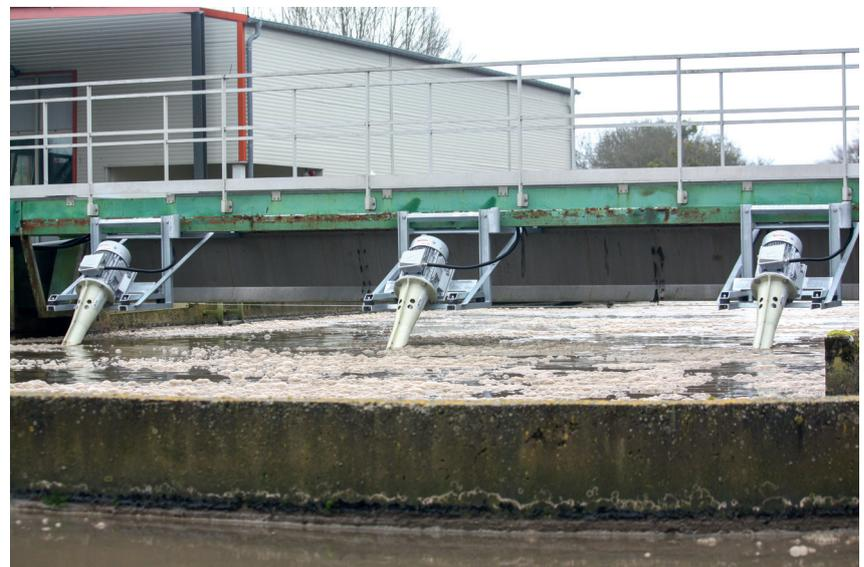
Remplacement de pont brosse sur structure métallique existante.
