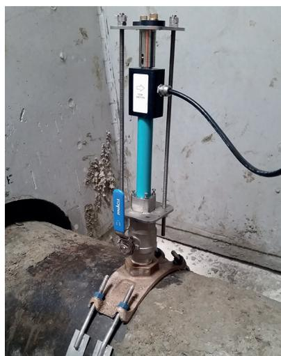
qu'elles mesurent chacune des segments d'aires égales. La moyenne des différents signaux de mesure fournit la vitesse moyenne dans la section avec une très grande précision. Le débit est calculé en multipliant la vitesse moyenne par l'aire de la section transversale du tuyau. Cette conception spéciale de la sonde multi-électrodes permet la mesure de divers profils d'écoulement, tels que les tourbillons et les turbulences.
