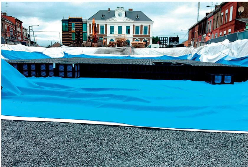
Simple de mise en œuvre, durable, autonome, et sans entretien, TenCate GeoClean® dépollue les eaux de ruissellement qui s'infiltrent dans le sol en retenant les hydrocarbures, et en amplifiant leur biodégradation.
